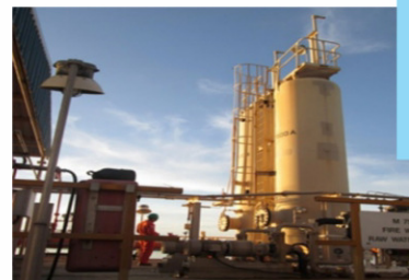
Fig. 2 Lighting Protection Installation PT Pertamina EP Subang (ITB Pertamina).
